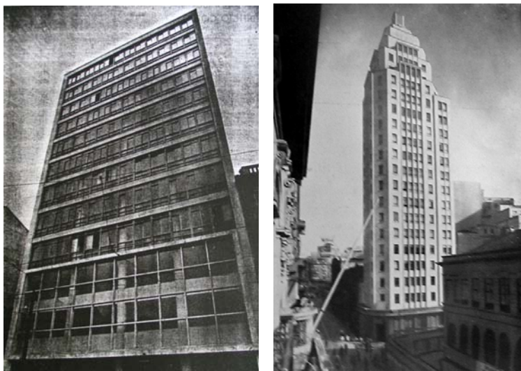
Edifício Cofermat ( fig.59) e Edifício Severo Vilares ( fig.60)
