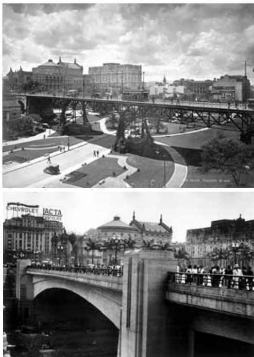
O antigo (foto de 1923) e o novo Viaduto do Chá (foto de 1940) (fig.39)
