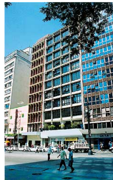
O edifício Vicente Filizola ( fig.47)
