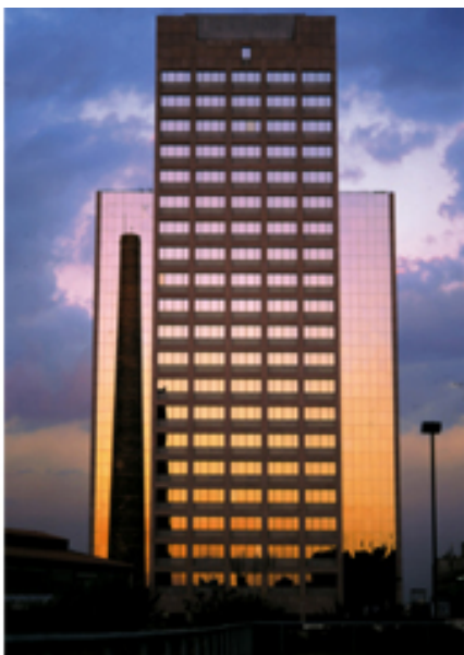
Água Branca – edifício concluído. ( fig.166)
