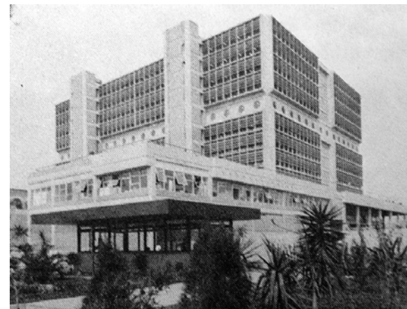
Centro Operacional do Itaú ( fig.110)
