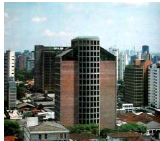
Edifício Atrium ( fig.136)
