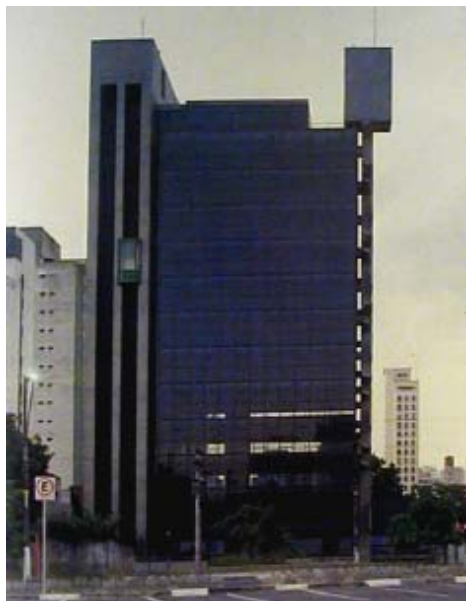
Edifício Keiralla Sarhan (fig. 133)
