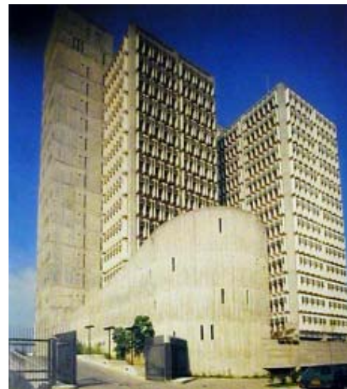
Condomínio São Luis (fig.132)
