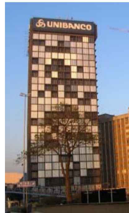
Edifício Nações Unidas (fig. 106a)
